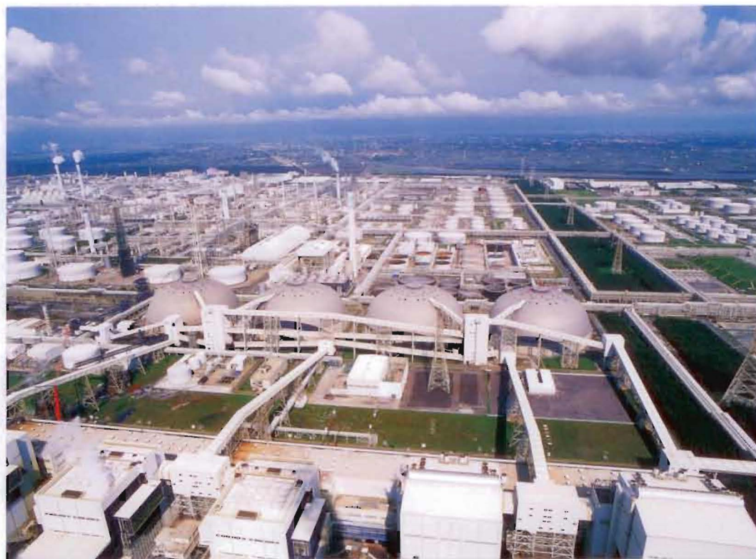
▲本企業廠區皆已設置自動化密閉式煤倉，以杜絕煤塵飛揚，確保空氣清淨
